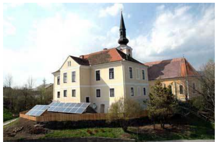
Die Pfarrkirche Dechantskirchen mit ihrer Photovoltaikanlage.
