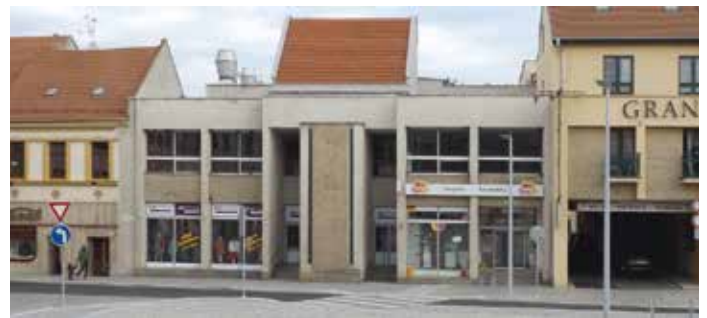
Der Neubau, Foto 2022.
