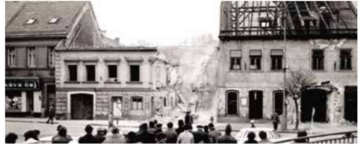
1974 wird das alte Felix-Haus abgerissen.
